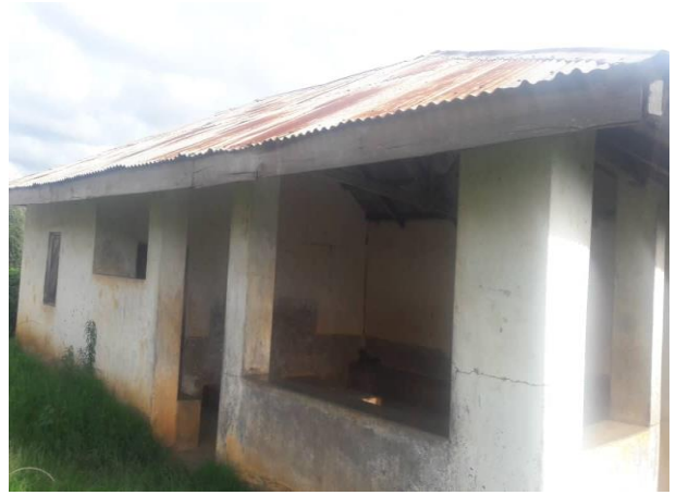
Picha: ikionyesha jengo la Mahakama ya Mwanzo Nongwe iliyojengwa mwaka 1954
